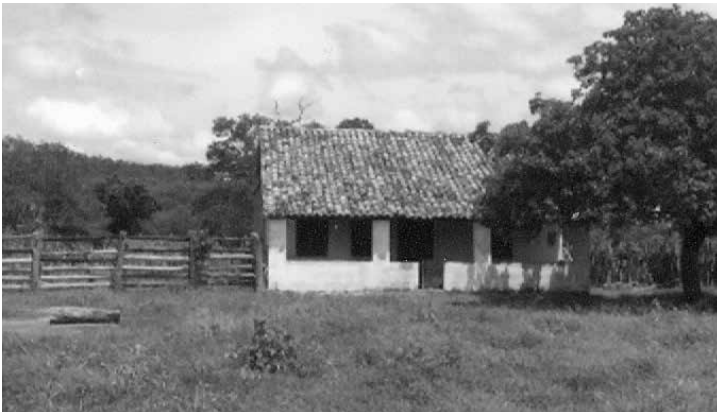
Casa onde residiu meu pai na fazenda “Buqueirão”, após a demolição da antiga casa-grande
